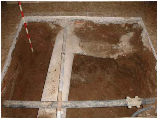
Vista de l'estat del sondeig a l'inici dels treballs arqueològics, amb els diferents serveis contemporanis.
