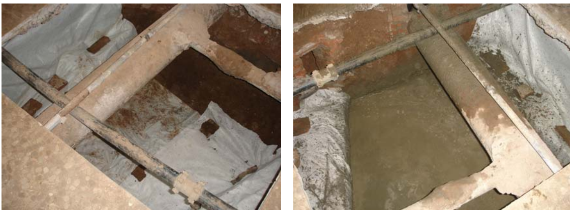
Vista final del sondeig protegit amb geotèxtil i amb el reompliment de formigó.
